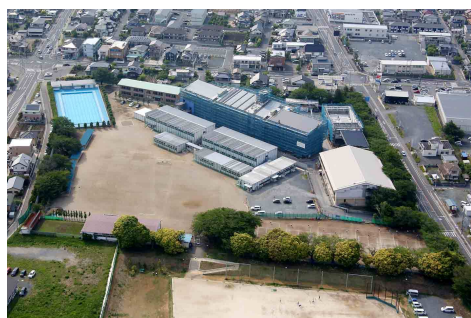
建設中の東海中学校（H26.5.24 現在）
