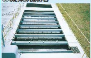
薬品を混ぜた原水中のドロなどを沈め、汚れを取ります。
