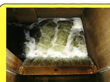
⑧〔塩素混和池〕 塩素（次亜塩素酸ナトリウム）により、大腸菌などの細菌を滅菌します。
