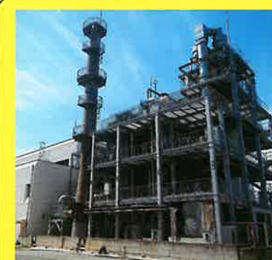
⑫〔焼却炉〕 脱水された汚泥の体積を小さくするため焼却し、体積を1/15～1/20程度にします。
