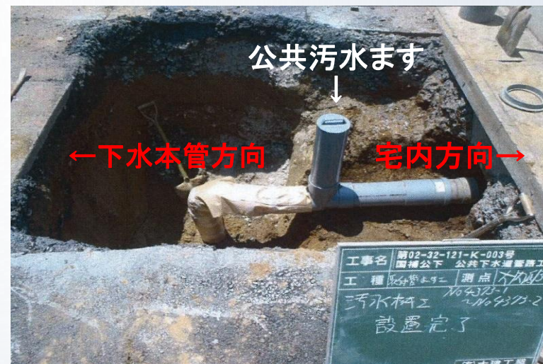
公共汚水ますの施工①
