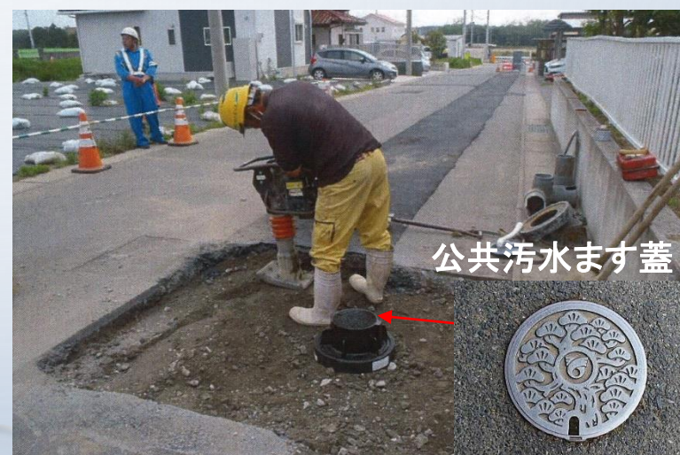
公共汚水ますの施工②
