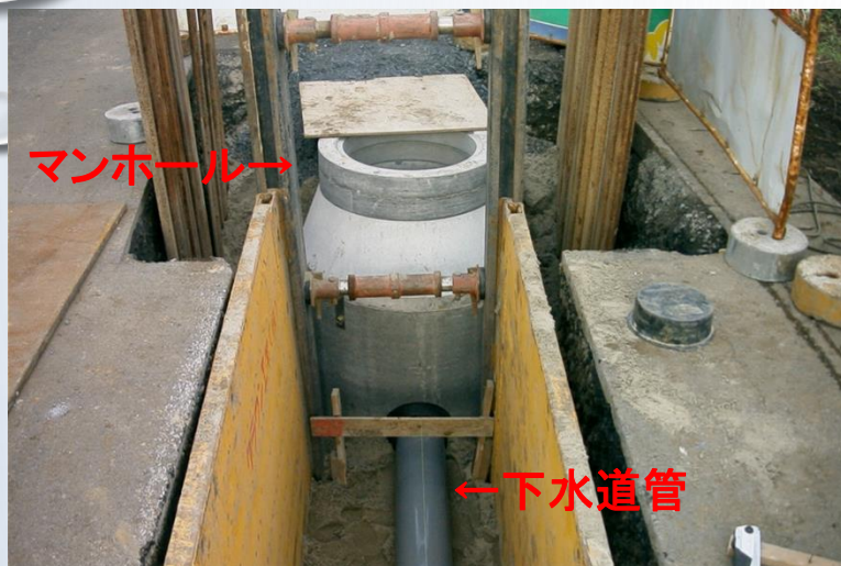
マンホールの施工
