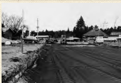
(昭和45年 駈上り-原燃線(国道6号への取り付け付近))
