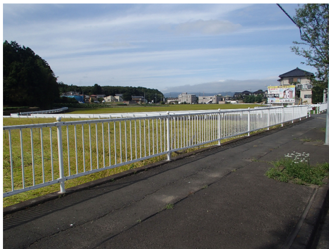
写真5：ガードレール・転落防止柵設置状況
