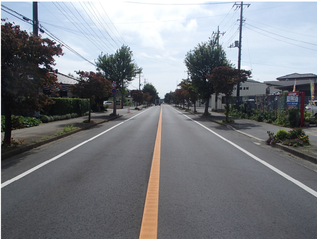
写真1：舗装の更新後の状態
