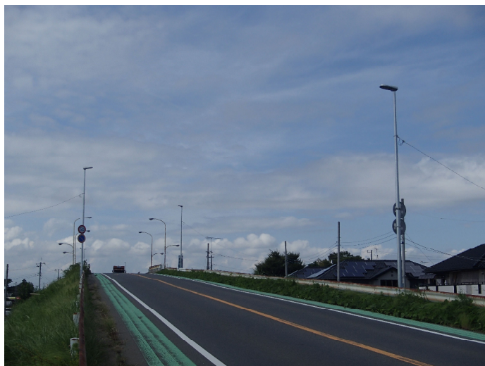
写真7：道路照明灯設置状況
