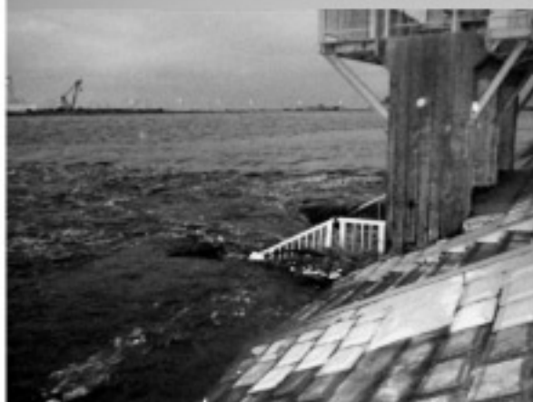
豊岡第1樋管久慈川取水口 17:56頃の模様
