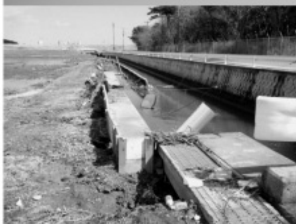
豊岡第1樋管内側排水路 3月12日 10:57頃の模様
