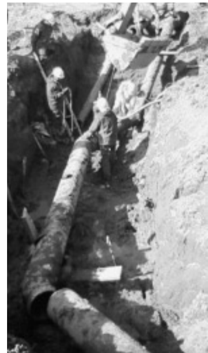
取水場付近の導水管
