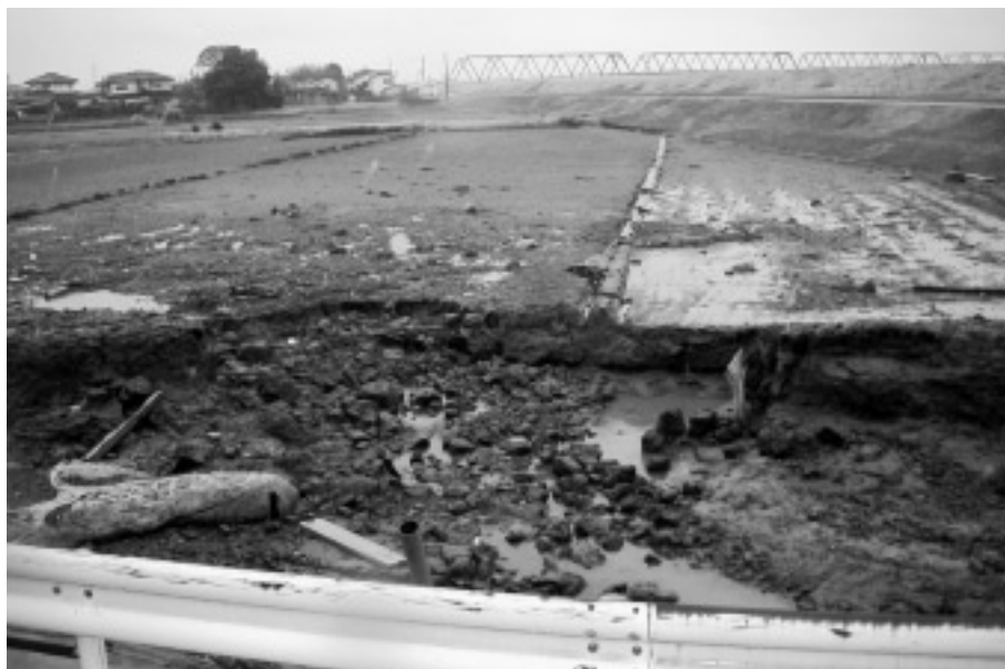
豊岡地区水門付近
