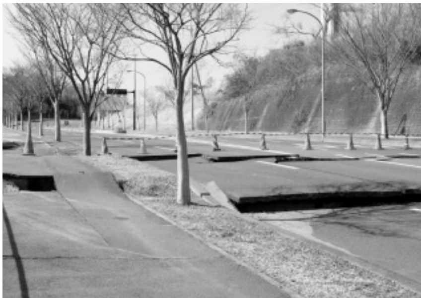
東海村総合福祉センター「絆」周辺
