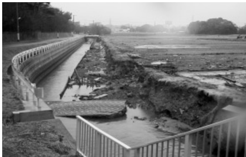
豊岡地区久慈川水門付近
