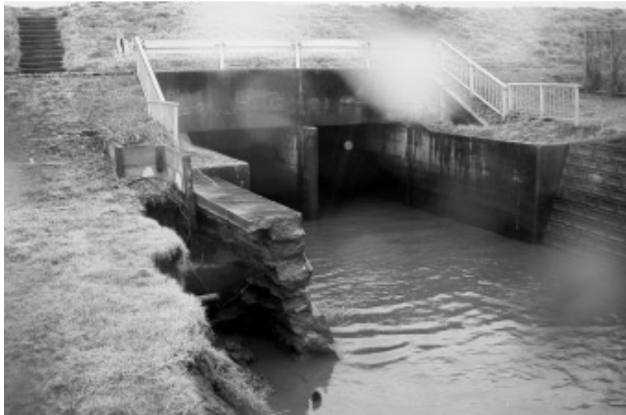
久慈川堤防水門
