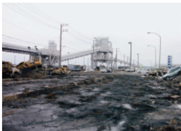
津波により火災を起こした車などを撤去して道路の確保を図る＝常陸那珂港区
