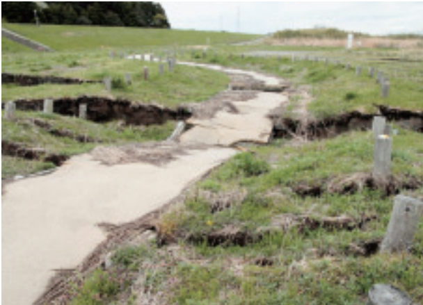
液状化で大破した遊歩道と津波の跡(植物片は津波漂着物)＝竹瓦芝野
