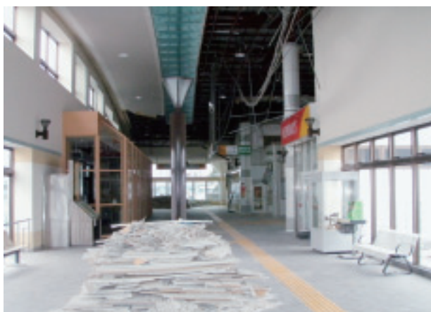
天井落下物の撤去＝東海駅
