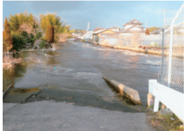
護岸を超える津波＝動燃通り新川根橋
