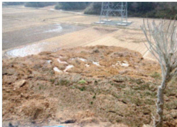
農地を覆った大量の土砂：崩落した土砂が，隣接の水田の半分まで埋め尽くしました＝南台住宅南側崩落斜面
