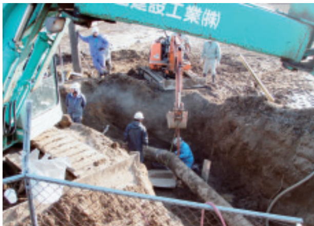
久慈川から取水する施設が被災し全村が断水しているため、懸命の復旧工事を実施＝那珂市（外宿取水口）
