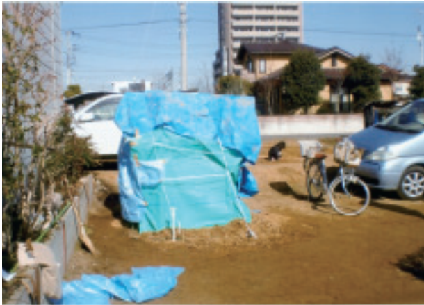
トマトの雨除用パイプでつくった仮設トイレ
