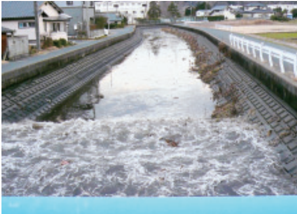
新川を遡上する津波＝動燃通り新川根橋上流
