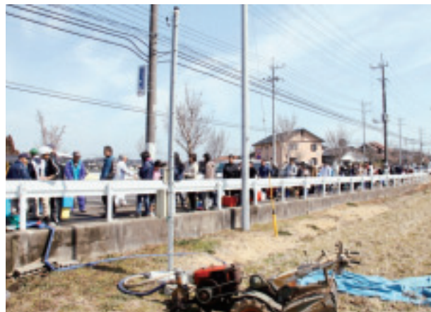
給水車だけでは間に合わず、田んぼ脇の井戸から、ポンプで水を汲み上げる
