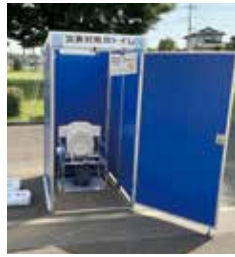
▲災害時用トイレ(マンホールトイレ)の設置
