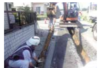
老朽化した水道管の更新
