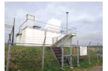
更新が必要な取水場
