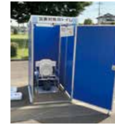
▲災害時用トイレ(マンホールトイレ)の設置
