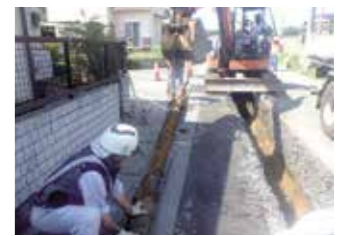
老朽化した水道管の更新
