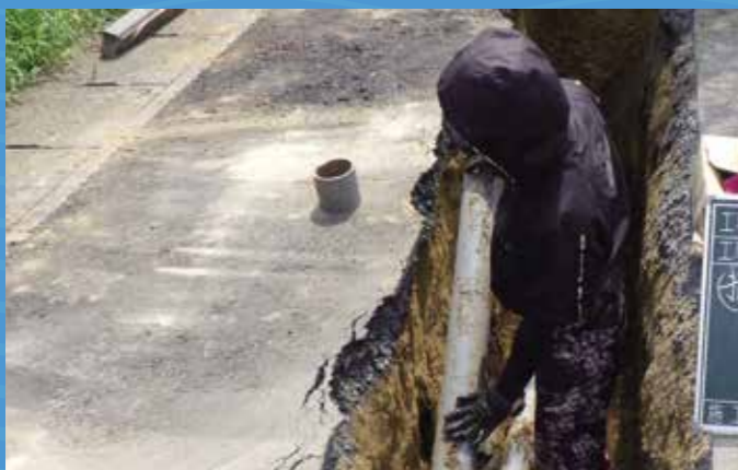
管工事で管路を敷設の様子 水道管も「当たり前」にあるものではないかもしれません
