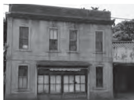
【写真① 村松軌道のレールが骨組みとなっていた建物】
